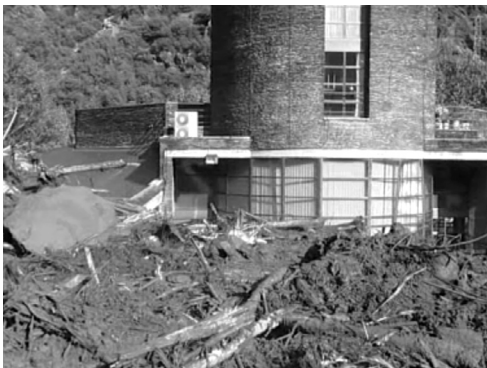
Foto 1. Amuntegament de sediments i de materials de diversa mena a la Duana Andorrana pel desbordament del riu Runer
